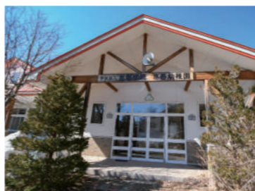
町民や町を訪れた人がいつでも利用できるリモート環境施設の実現に向けて改修が進められる旧葛巻幼稚園舎
