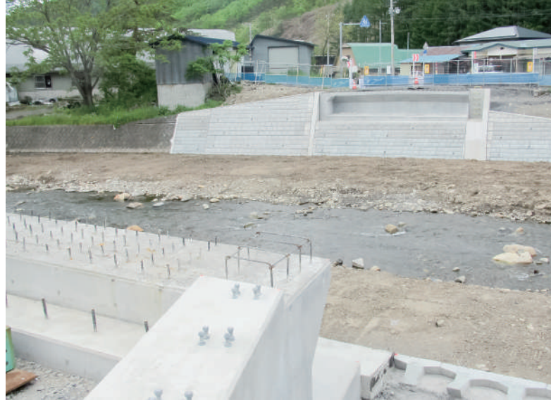
荒沢口橋の架け替え工事
