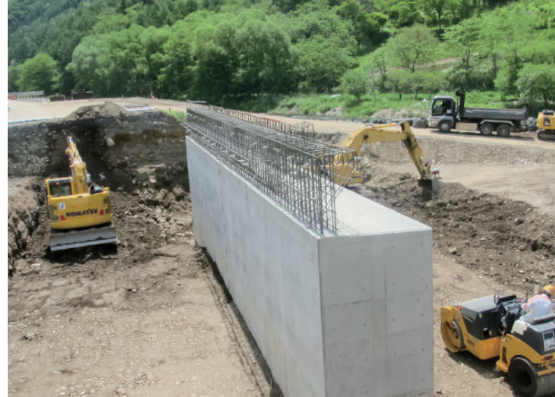
大橋の架け替え工事
