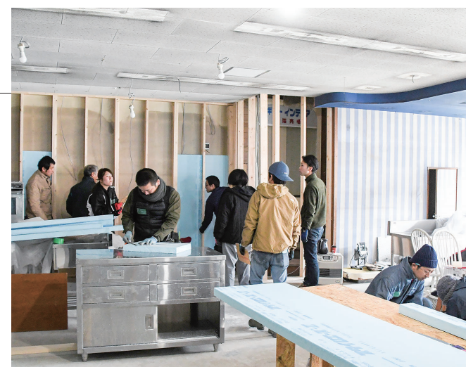
断熱材を切り分け次々と壁にはめ込んでいく参加者たち
