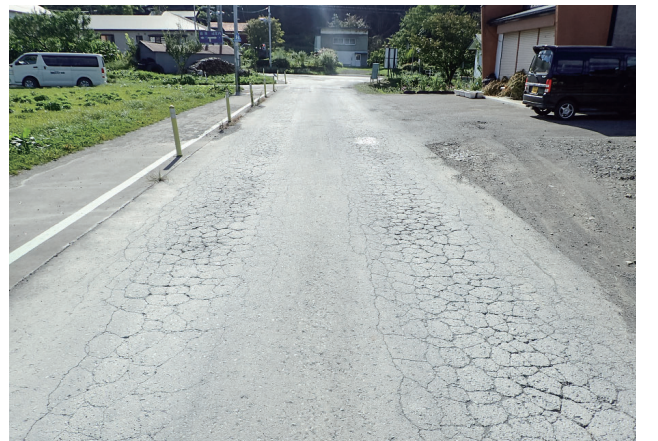
修繕工事を行う五日市袖山線
