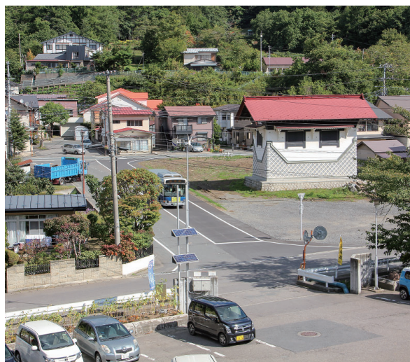
道路幅が広がった町道役場線
