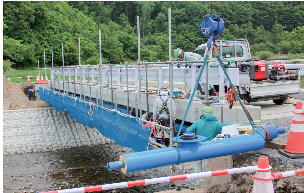
江刈地区水道の水道管布設工事（追鍋橋・栗山地区）
