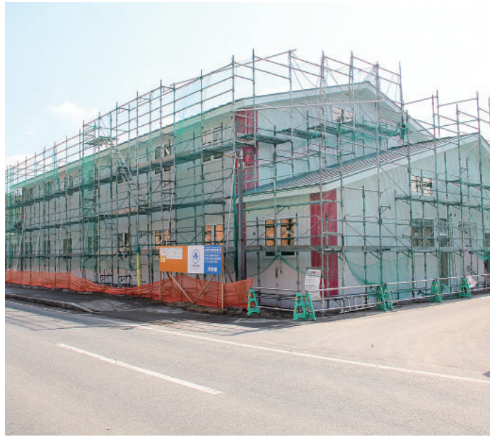
山村留学生が入舎する寄宿舎（グリーンテージ東側）
