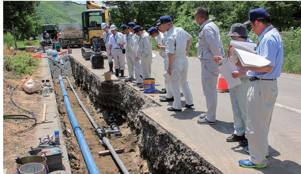
整備工事が進む 江刈地区水道（泥這地区）
