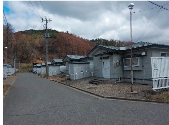
経年劣化が進む町営住宅
