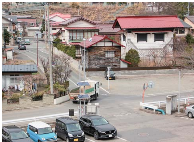
町道役場線を拡幅整備することで、役場と病院への交通の便が良くなると期待されます。
