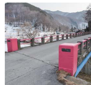
▲老朽化が進む大橋の架け替えを含めた道路の幅を広げる工事を行い安全性や快適性、利便性の向上に努めます
