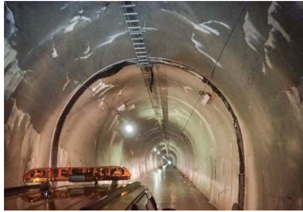
点検予定の上外川トンネル
