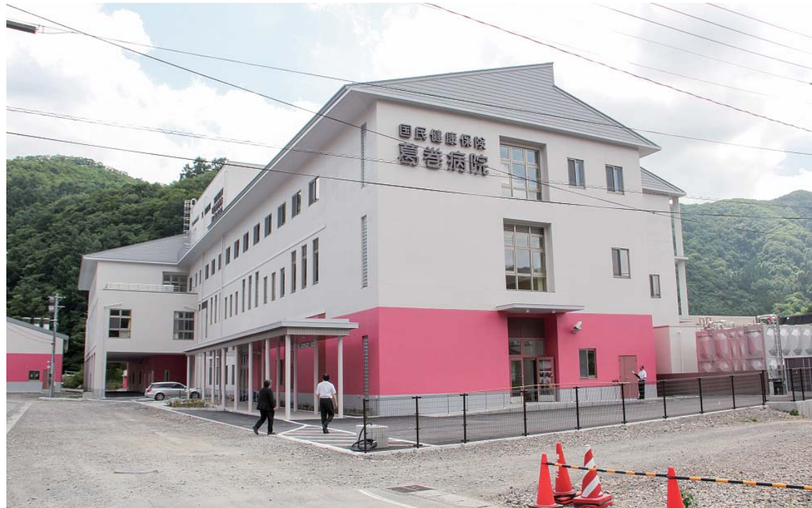
完成した新葛巻病院
