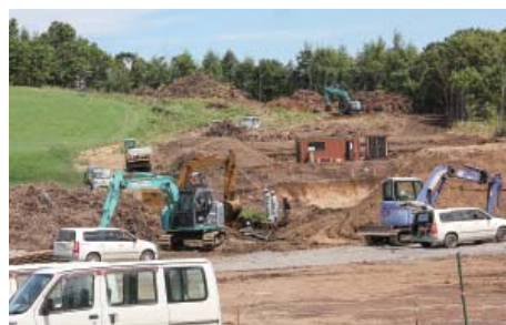
造成工事が進むくずまき第二風力発電所
