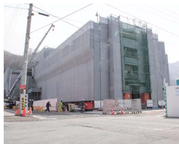
建設が進む新葛巻病院
