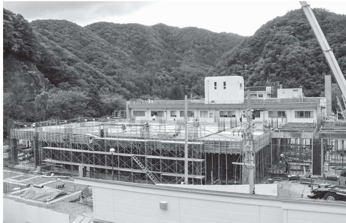
着々と進む新病院の改築工事
