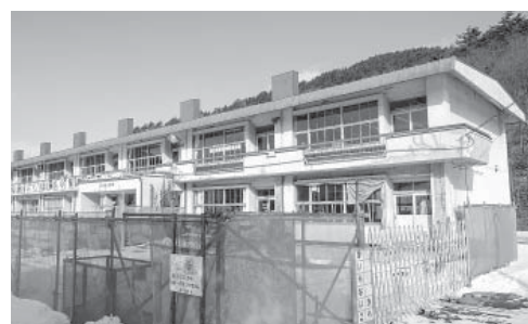
耐震化補強工事が進む小屋瀬小学校
