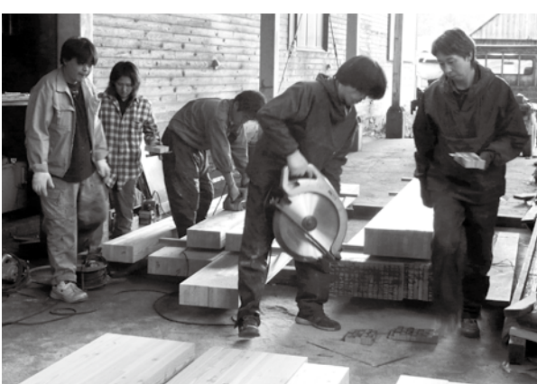
集成材加工現場(有限会社高吟製材所)
