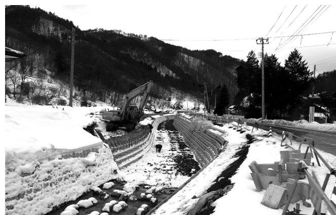
星野川 災害復旧工事現場
