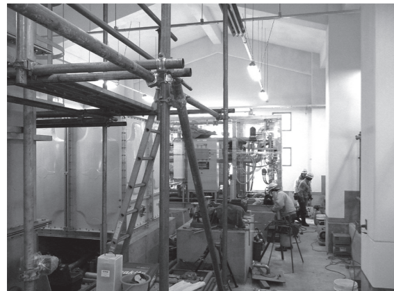
西部簡易水道施設 屋内工事
