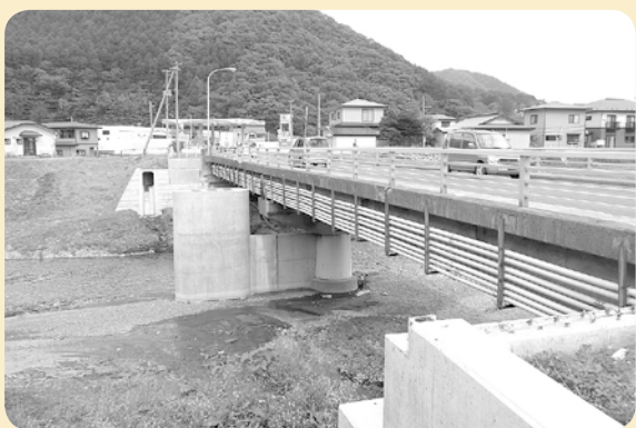
歩道設置が待たれる堀の内橋
