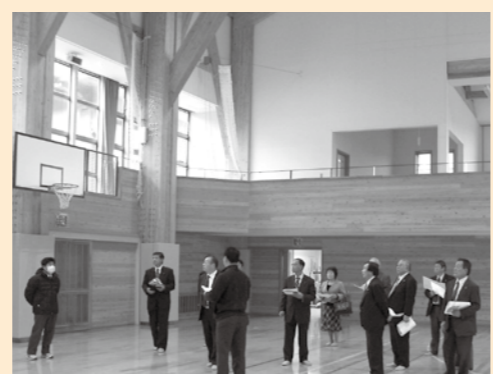
カラマツ集成材を使ったあたたかさやすらぎを感じる、伊南中学校体育館
