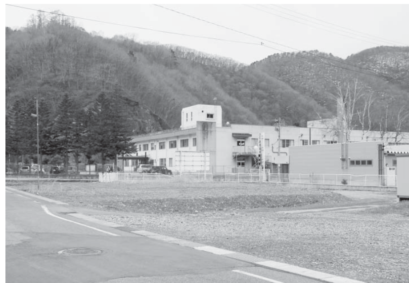
新葛巻病院の建設予定地
