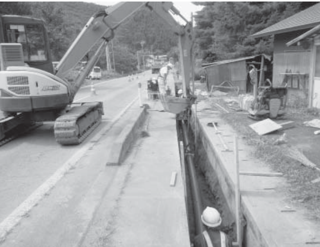
新たな水道管を設置（江刈馬淵地区）
