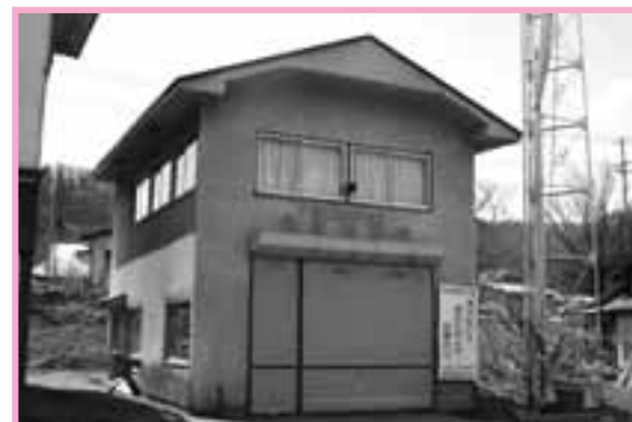
老朽化が激しい第14分団屯所
