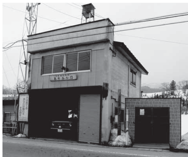
購入後23年経過した第12分団ポンプ自動車と屯所
