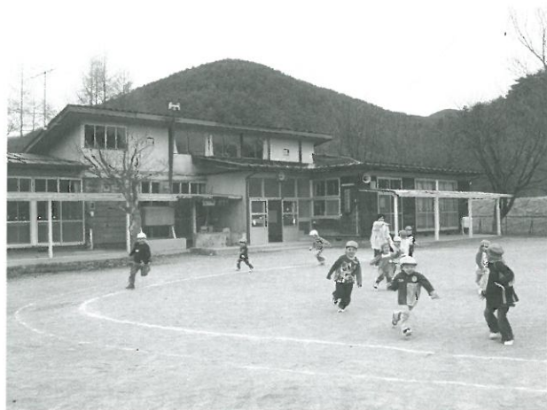
築40年が経過し老朽化の進む五日市保育園
