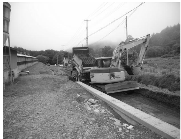
町道の修繕工事の様子
