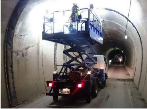
写真-5 トンネル点検車による近接目視
