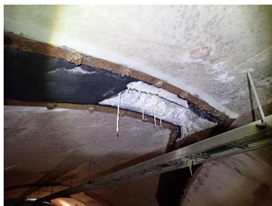
写真-4 漏水対策工破損部からの漏水
