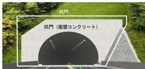
図-4 トンネル点検対象箇所
