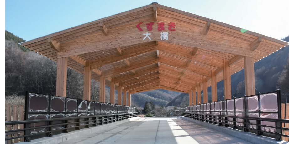
令和4年3月に完成した大橋の木製上屋
